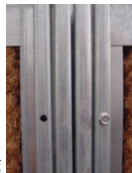
Les poteaux peuvent être préalablement percés
